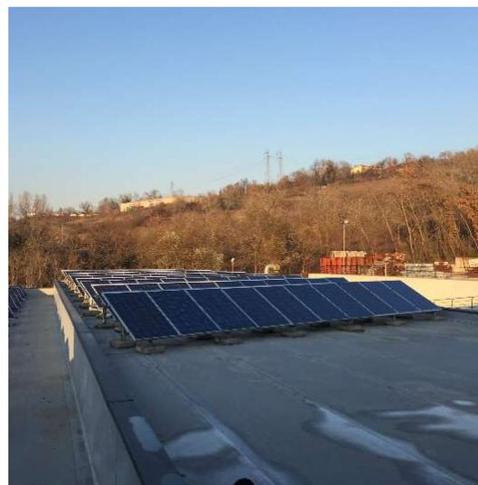
L'impianto in parola è un impianto di produzione di energia elettrica da fonte solare fotovoltaica della potenza nominale di **19,84 kWp** ( diciannove/84 kiloWattpicco lato corrente continua), incentivato in secondo conto energia ed in regime di scambio sul posto. ( *riferimento fotogramma 29 – allegato 1* )
